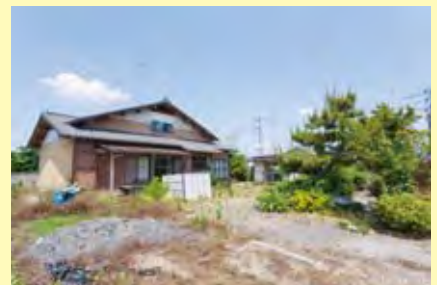
上／リフォーム再販の一例。敷地は273.9㎡、建物は築31年の木造軸組み工法の一戸建て118.8㎡。リフォーム後は、建物と庭を整えている 下／リフォーム前の様子
