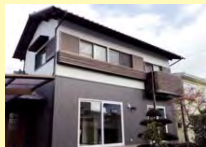
上／下の一戸建てのリノベ後のダイニング。対面キッチンやカウンターを新設した 下／リノベーション再販の一例。リノベ後の外観。築25年、木造軸組工法の一戸建て。敷地面積209.82㎡、延床面積111.99㎡
