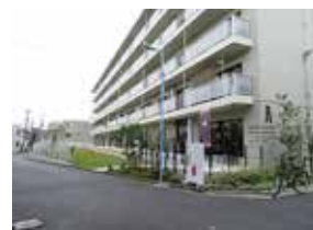
杉並区高円寺の社宅をリノベーションしたアールリエット高円寺。1階にテナント区画、それ以外にも店舗兼住宅、アトリエ兼住宅という区画もあり、住むだけではない多機能ぶりが話題になった。
