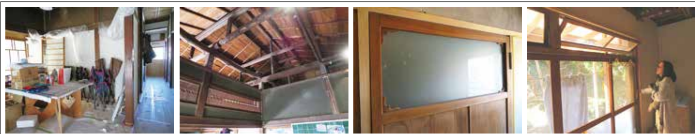
玄関土間、玄関脇などあちこちが作業中。どう手を入れるか悩んでいる部分もあるとか。既存建物は細かい部分の意匠、使い勝手が秀逸とその部分はできるだけ残して使う予定だ
