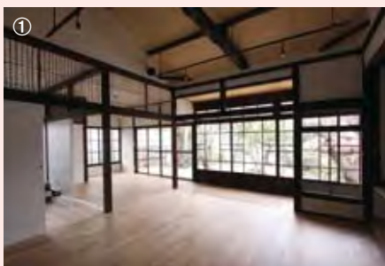
①【1930の家】一部欄間の土壁は丁寧に土を取り除き、竹小舞を残して透過スクリーンのように仕上げた ②【ビジネスインのむら】ホテルらしい風情を残した正面玄関 ③【ビジネスインのむら】カーペットの模様が「三畳一間」の客室の記憶を伝えている
