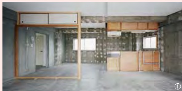
①【sayama flat】埼玉県狭山市。1フラット100万円という限られた予算で手がけられた地上7階建ての集合住宅の1棟改修(写真 太田拓実)
