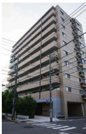
三ノ輪アパートの跡地に建設されたマンション
