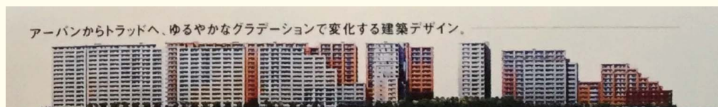
10棟をこす建物が連なる。写真は全て『ハウス アドバタイジング・グラフィックス』(ピエ・ブックス) 所収
